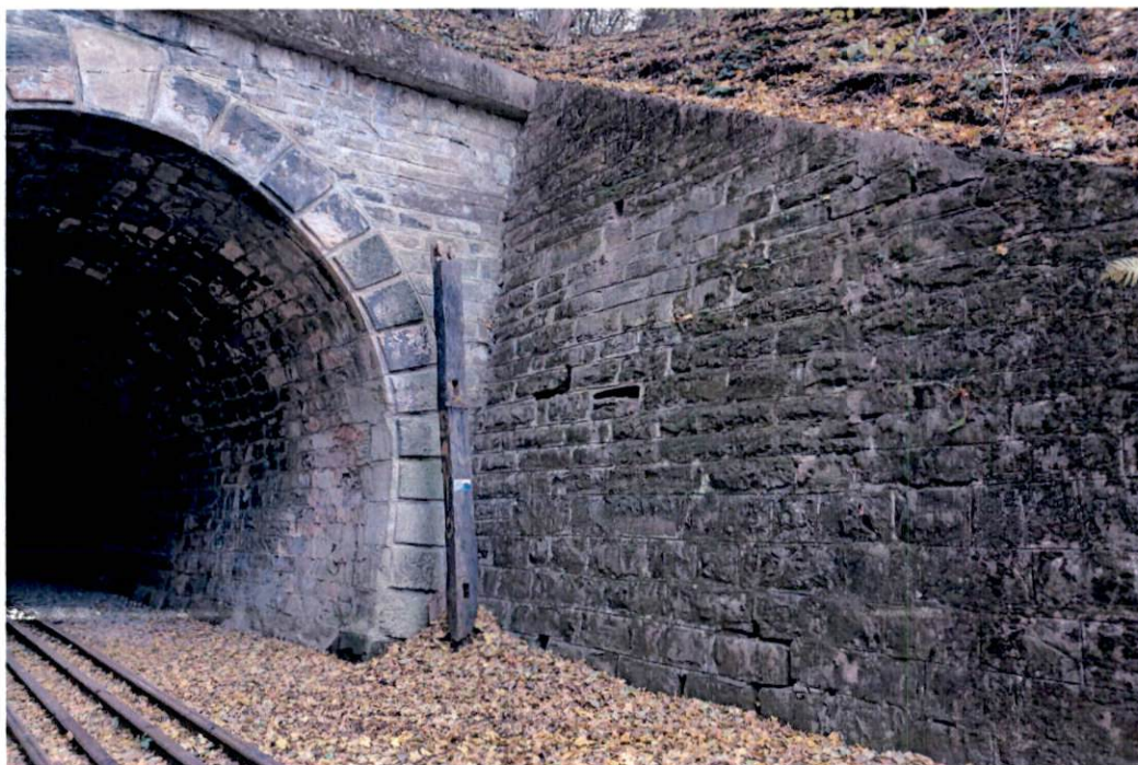
Fot. 2. Pd-wsch. ściana oporowa z bloków kamiennych oraz słup konstrukcji niezachwianej wiaty. Widok od pd. z poziomu torowiska
