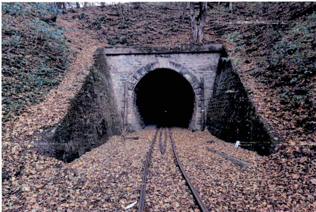
Fot. 1 ściana czołowa i boczne ściany oporowe o konstrukcji z bloków kamiennych. Ważnym elementem jest zachowane boniowane obramienie wjazdu. Po bokach dwa zachowane słupy – jedyny relikw zniszczonej wiaty. Na pierwszym planie betonowe obramienia torów kolejowych
