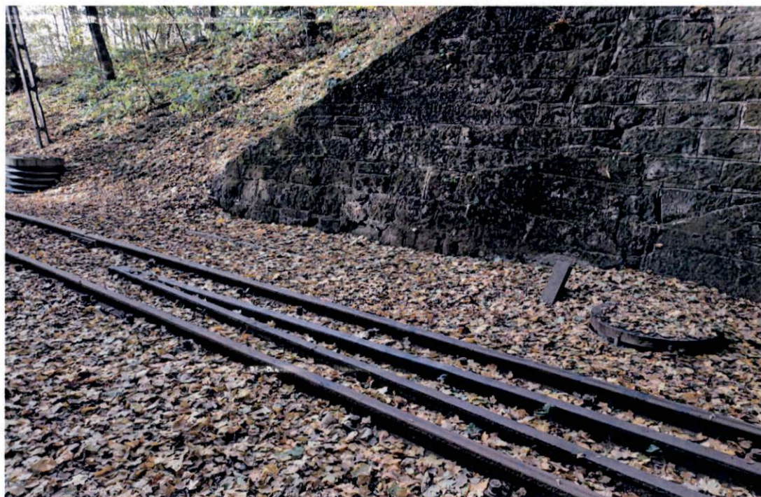
Fot. 10. Fragment pn.-zach. ściany oporowej. widoczne są betonowe uzupełnienia – prawdopodobnie w miejscu uszkodzenia dolnej części ściany. Obok ściany betonowe
