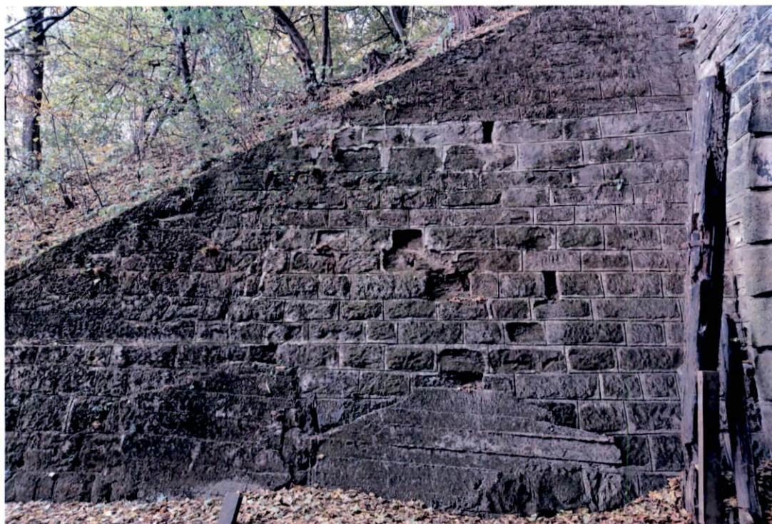
Fot. 7. Fragment pn.-zach. ściany oporowej z bloków kamiennych oraz słupa konstrukcji niezachowanej wiaty. widoczne są otwory odwadniające, uszkodzenia mrozowe konstrukcji ściany oraz uszkodzenia słupa.
