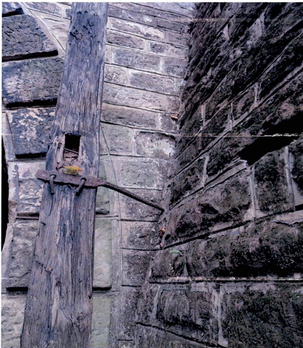
Fot. 6. Zachowana kotwa mocująca pd.-wsch. słup konstrukcji niezachowanej wiaty do ściany oporowej. Powyżej kotwy widoczne jest gniazdo niezachowanej poziomej belki konstrukcyjnej.
