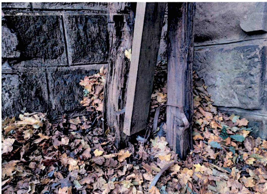
Fot. 8. Dolna, uszkodzona część pn.-zach. słupa konstrukcji niezachowanej wiaty. Widoczna jest zachowana obejmą mocująca słup do ściany oporowej.
