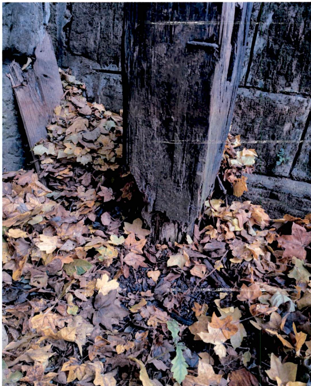
Fot. 5. Dolna część pd.-wsch. słupa konstrukcji niezachowanej wiaty. Widoczna jest zdeformowana obejma mocująca pierwotnie słup do ściany oporowej.
