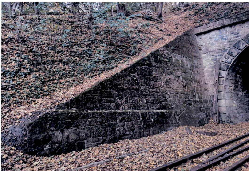
Fot. 3. Pn.-zach. ściana oporowa z bloków kamiennych oraz słup konstrukcji niezachowanej wiaty. Widok od pd. z poziomu torowiska
